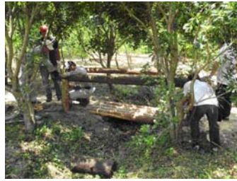
散策道に丸木橋を設置
